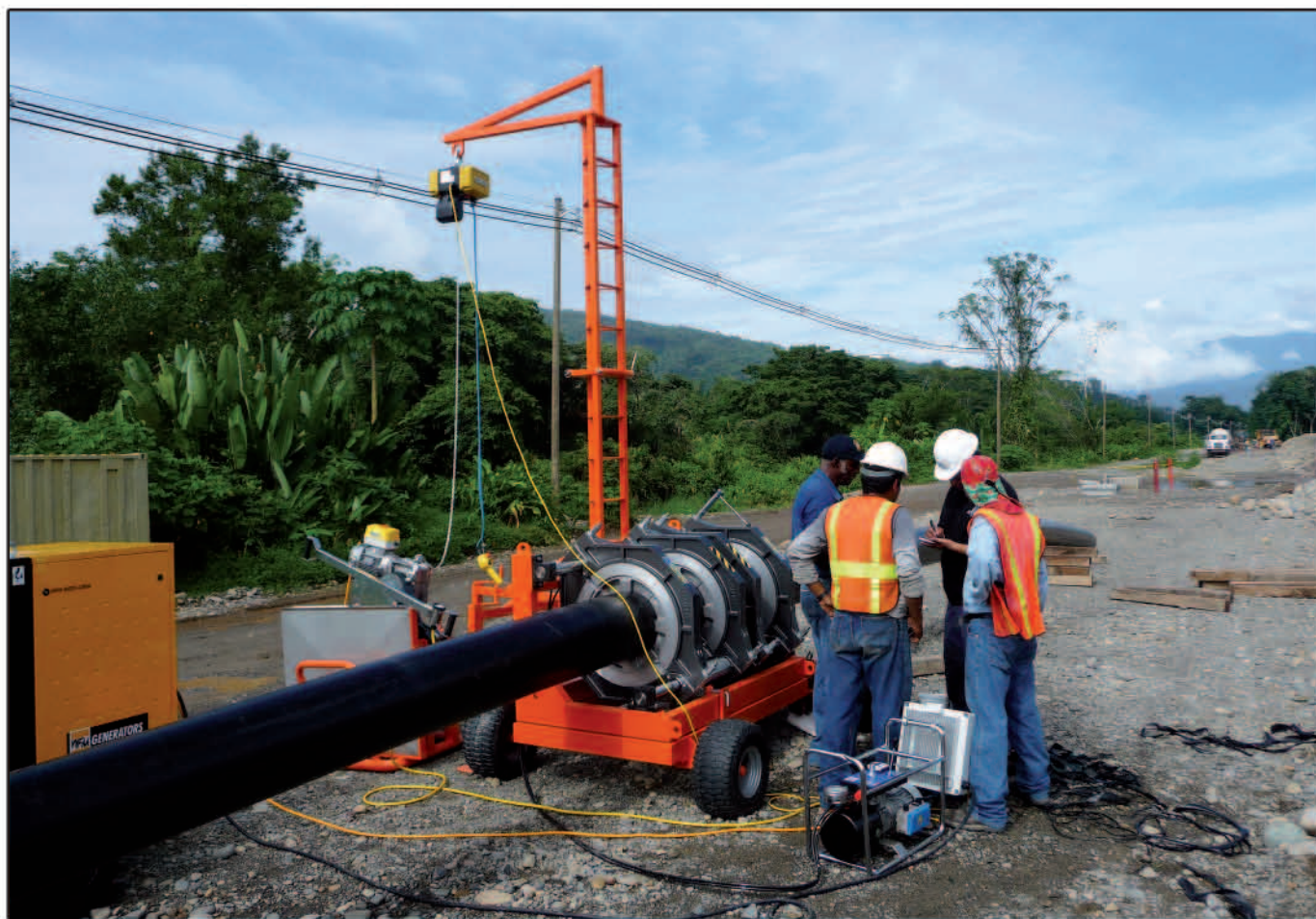
Удаление торцевателя
